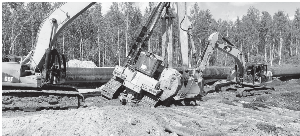
Ремонт одного из участков газопровода
