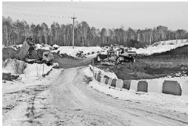
➤ Идёт строительство моста в Скрипкино // Фото Татьяны СУХОВОЙ
