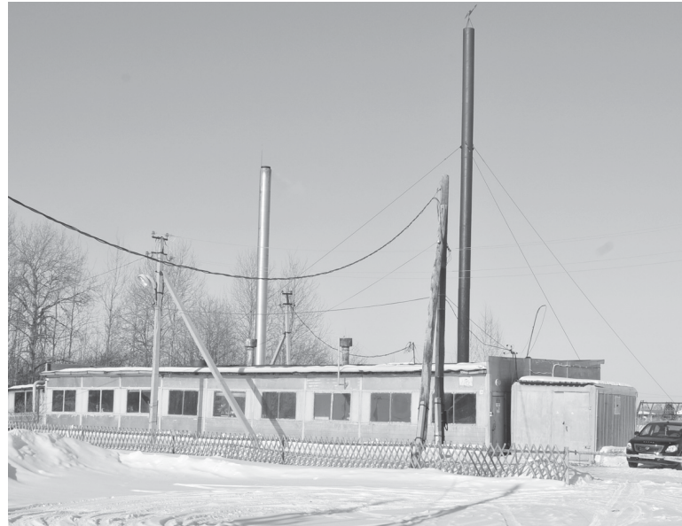
В 2022 году в Гилёво появилась новая газовая котельная
