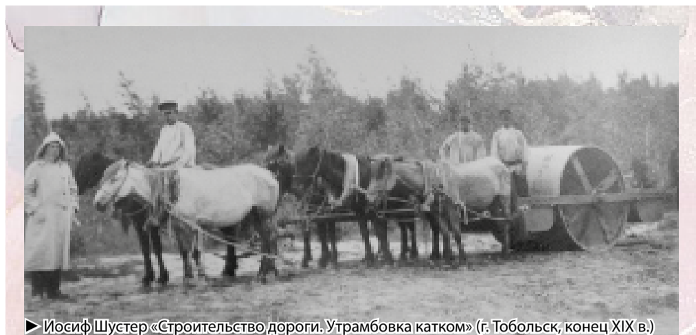
► Иосиф Шустер «Строительство дороги. Утрамбовка катком» (г. Тобольск, конец XIX в.)
