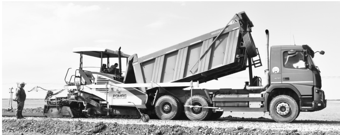
Летом 2022 года проведен ремонт дороги Полозаозерье - Кутырево
