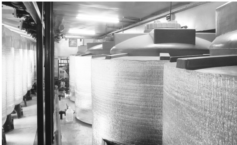
Современные системы водоочистки были установлены в Окунево, Зарослом и Уктузе
